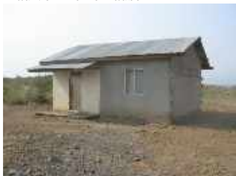
Bau von Lehrerhäusern
