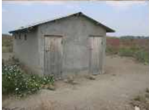
Erweiterung von Toiletten
