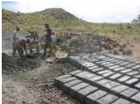
Bau von Klassenzimmern
